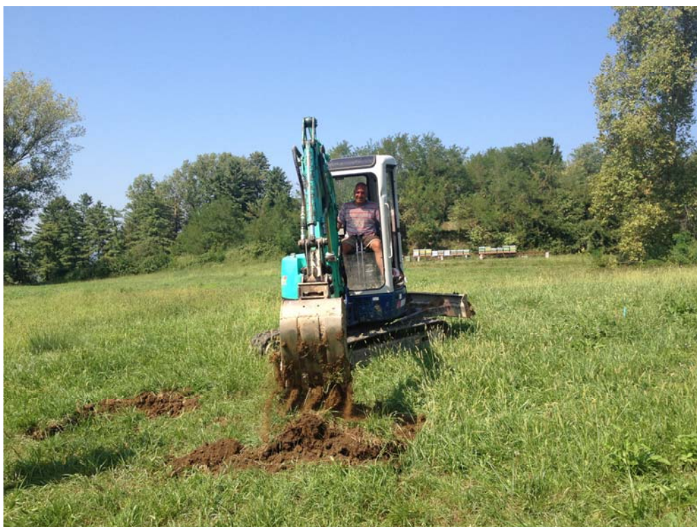
Foto 4 : Cimitero di Tabiago – Esecuzione saggio di scavo
