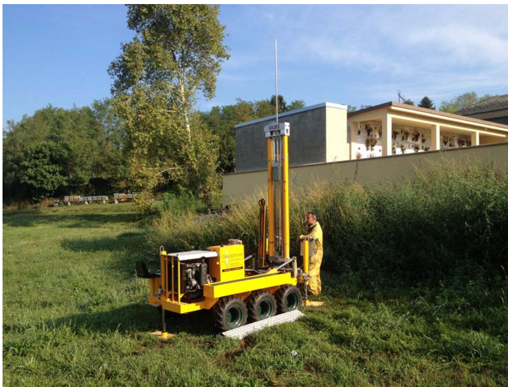
Foto 1 : Cimitero di Tabiago – Prova penetrometrica S.C.P.T. 1
