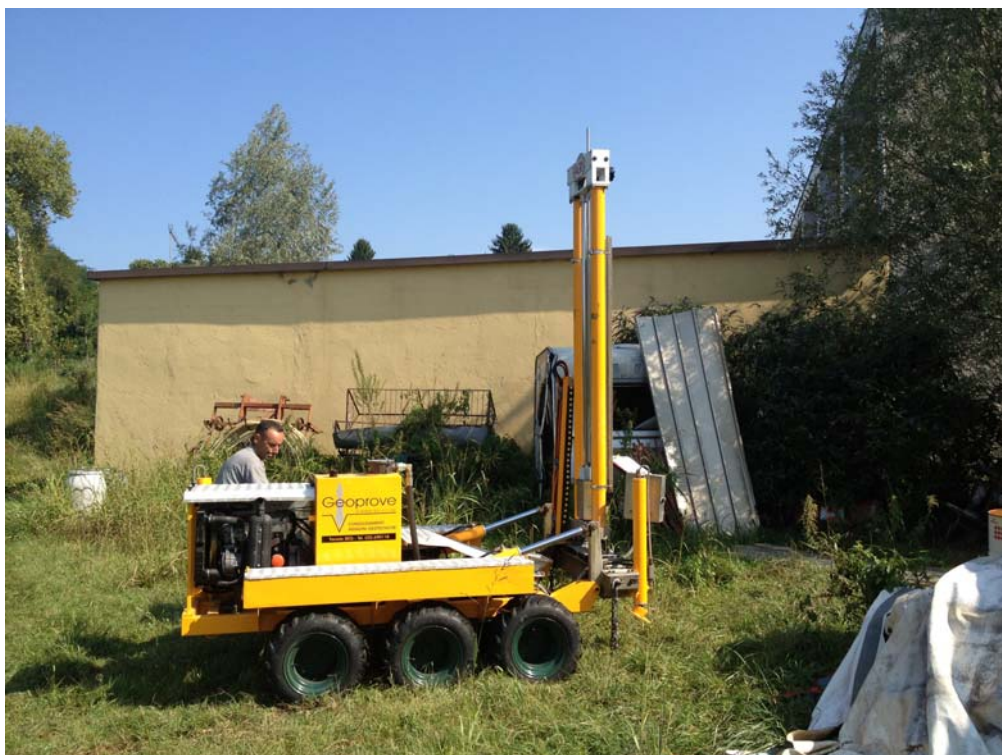
Foto 4 : Cimitero di Tabiago – Prova penetrometrica S.C.P.T. 4
