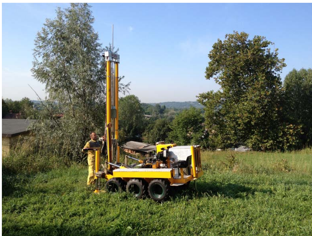
Foto 2 : Cimitero di Tabiago – Prova penetrometrica S.C.P.T. 2
