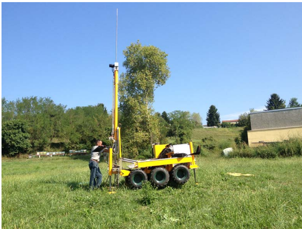
Foto 5 : Cimitero di Tabiago – Prova penetrometrica S.C.P.T. 5
