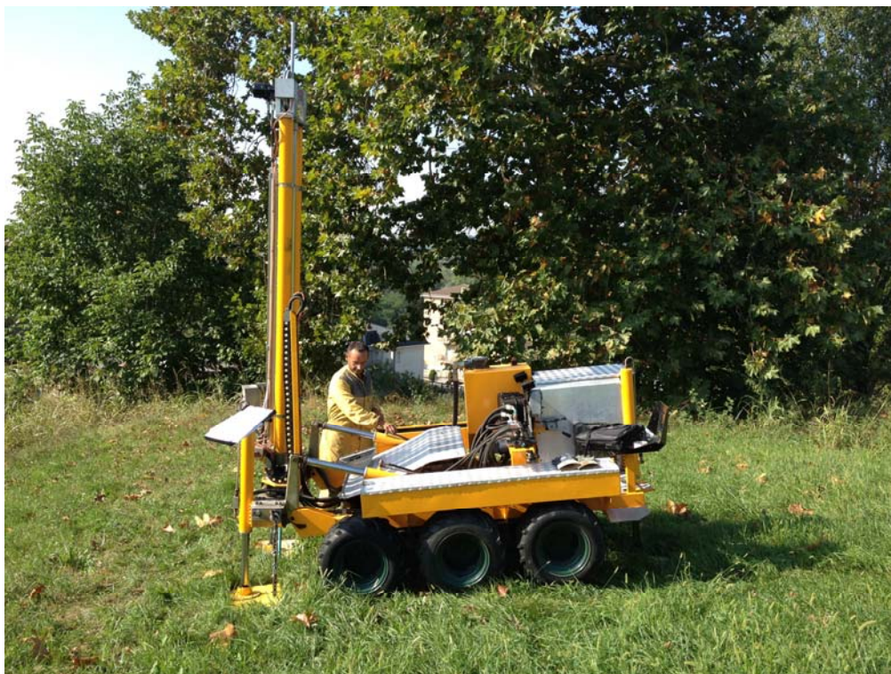
Foto 3 : Cimitero di Tabiago – Prova penetrometrica S.C.P.T. 3
