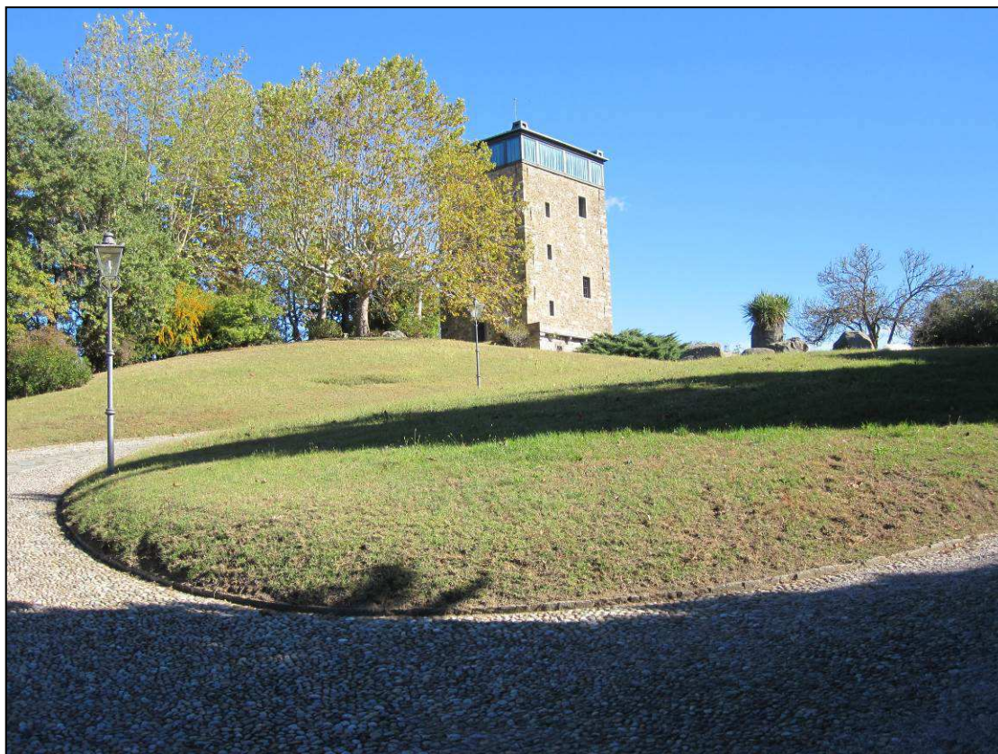
La torre di Tabiago
