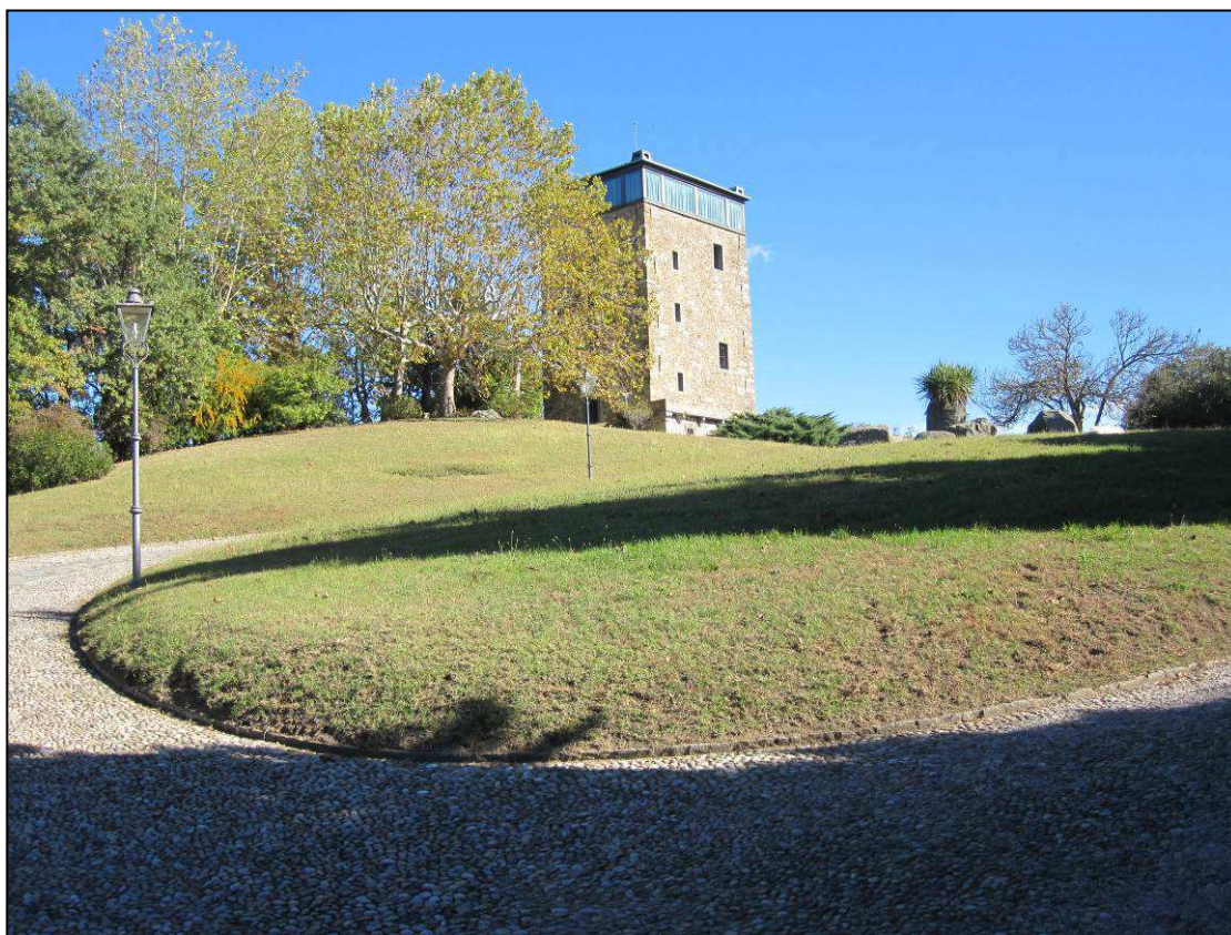
La torre di Tabiago
